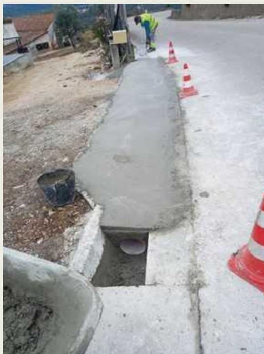
O município de Ferreira do Zêzere realizou, em todo o concelho e de forma faseada, intervenções de manutenção e reparação de aquedutos e cortinas nas vias municipais, com o objetivo de melhorar as condições de segurança e circulação rodoviária e assegurar o correto escoamento das águas pluviais.
