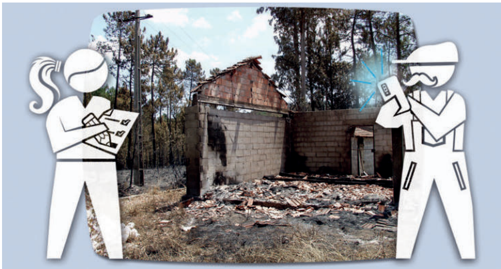
Fig. 77 Avalie os danos no edificado.
