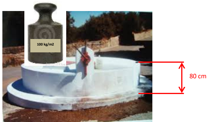
Figura 22 – Poço com cobertura e resguardo eficaz
