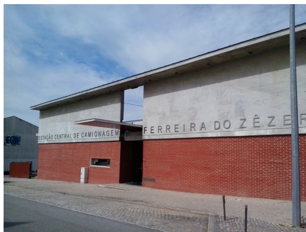
200 | Estação de Camionagem de Ferreira do Zêzere
