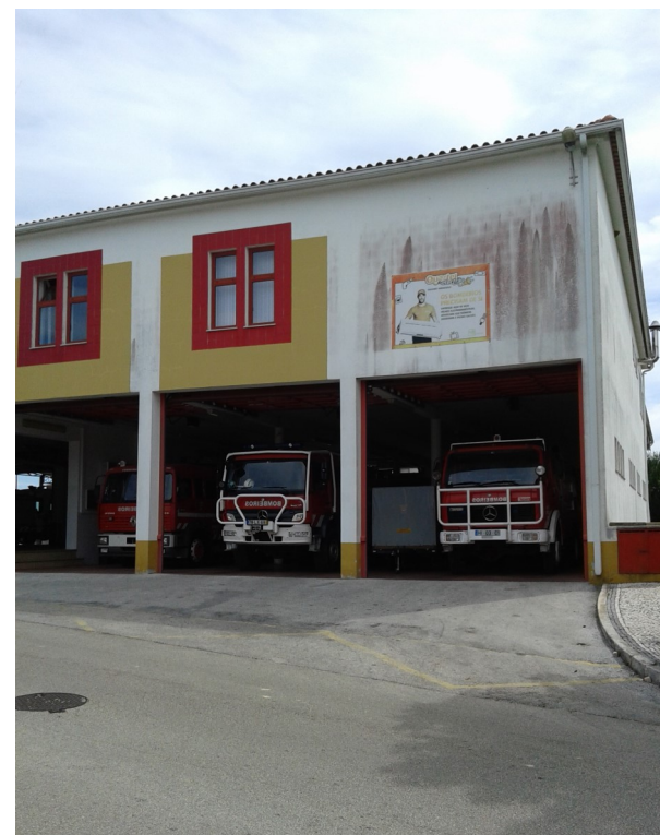
173 | Edifício dos Bombeiros
