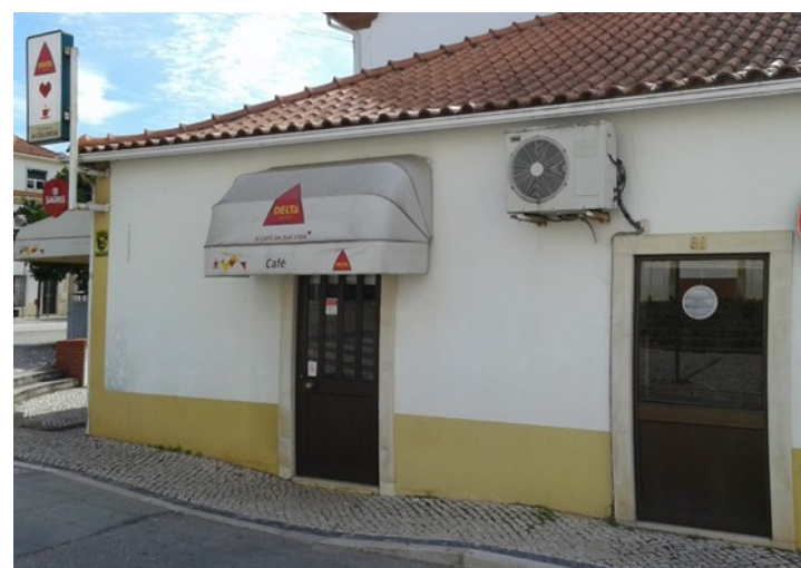
79 | Presença de máquinas de AC
