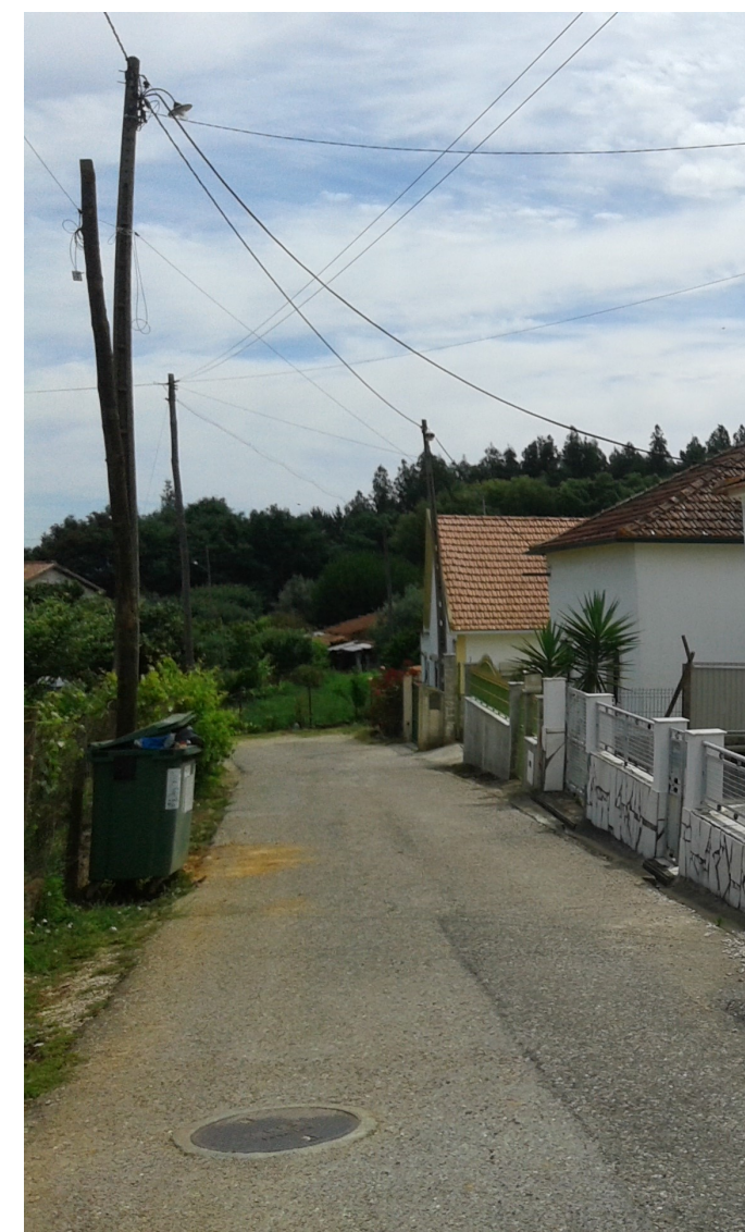
201 | Exemplo de cabos aéreos
