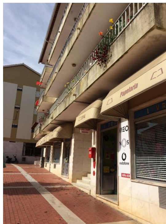
81 | Fachada com toldo de sombreamento associado ao estabelecimento comercial do piso térreo
