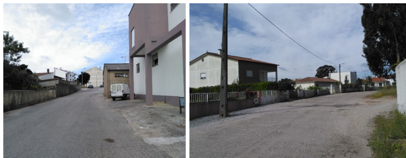
123 | 124 | Exemplos de arruamentos em zona residencial passíveis de intervenção
