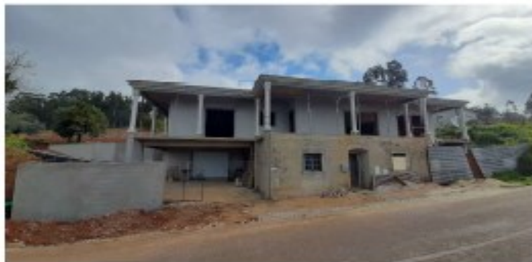
Foto nº 2 (ampliação do edifício existente e execução de muro de vedação confinante com a via pública)
