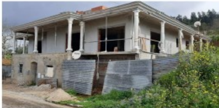
Foto nº 1 (ampliação do edifício existente)
