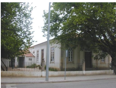
Foto 3: Edifício da Creche (Escola Conde de Ferreira)
